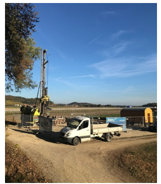
Bohrgerät beim Bohrplatz Marthalen-Oobist
